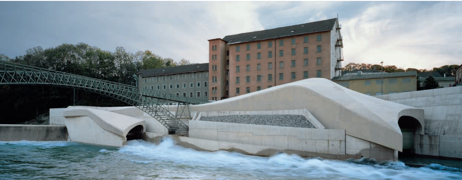
Wasserkraftwerk Kesselstraße, Kempten, Konstruktionsgruppe Bauen AG, Kempten, Foto: Brigida González
